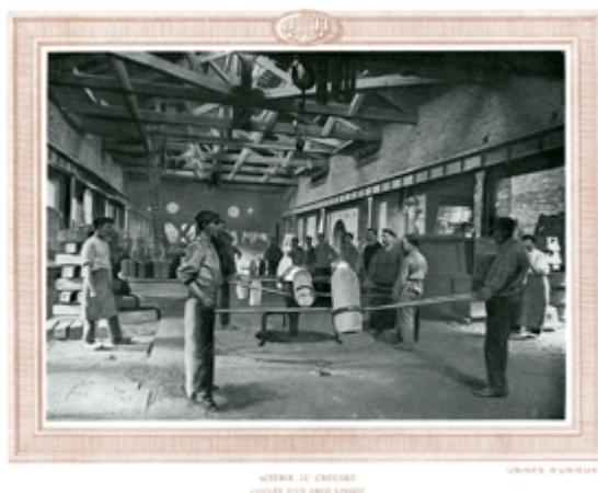
Coulée d'un gros lingot à l'aciérie Holtzer Collection Puits Couriot/ Parc-Musée de la Mine
