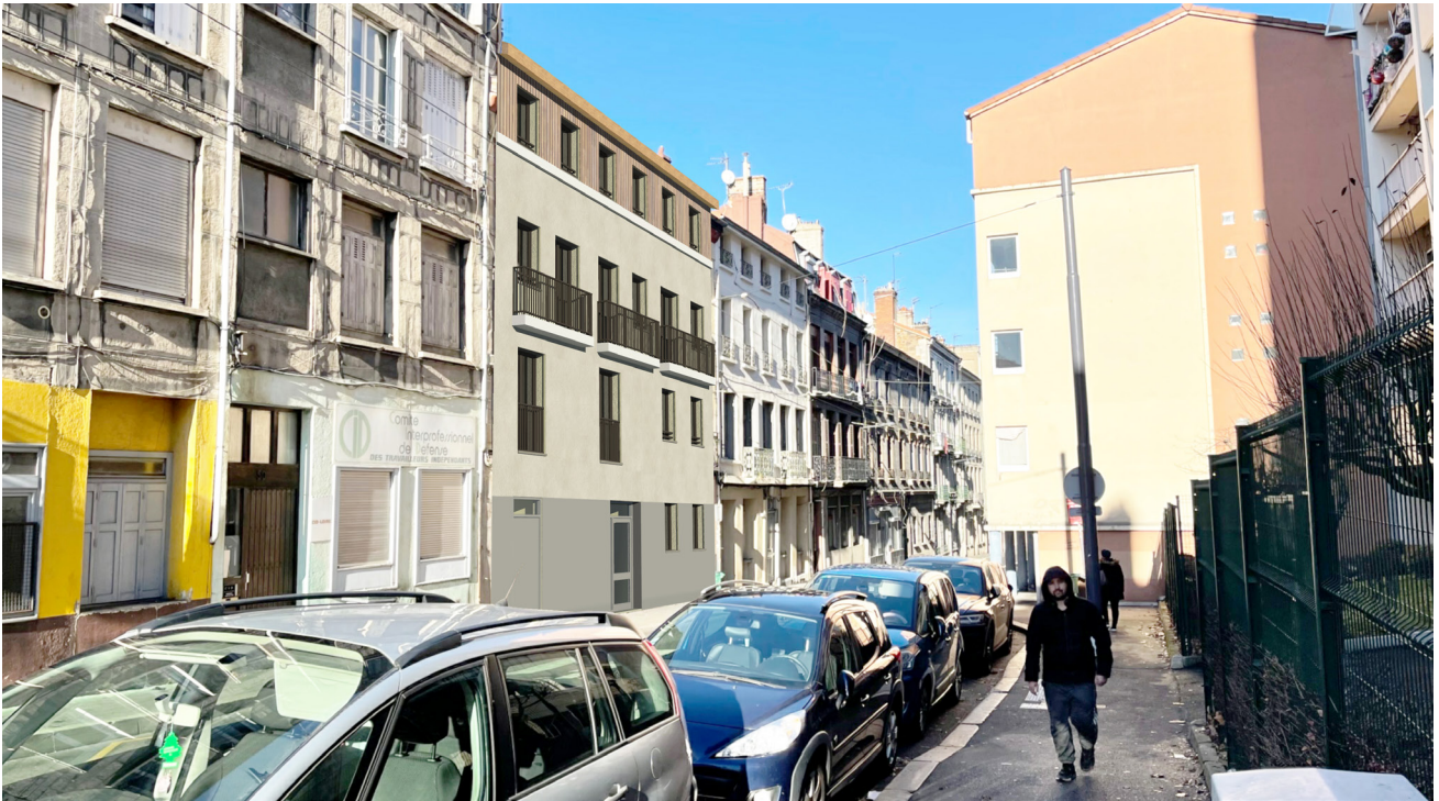
Résidence rue Beaubrun - ©Projet D - Architecte - Perspective non contractuelle
